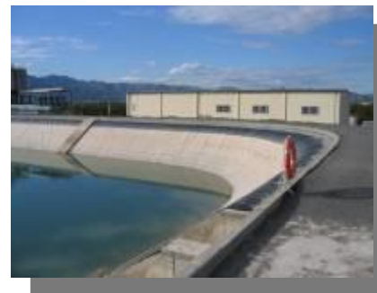
Cabezal y depósito Sector 4-5
