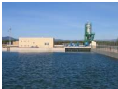
Cabezal y depósito Sector 3
