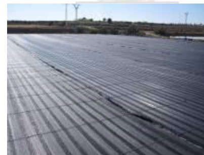
Cubierta de depósito
