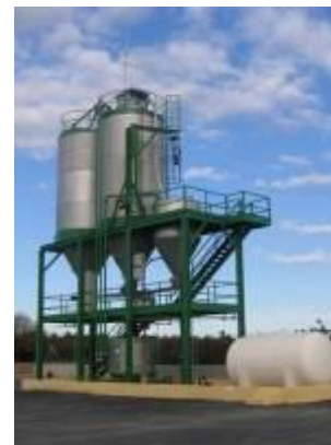
Estación de abonado Sector 3
