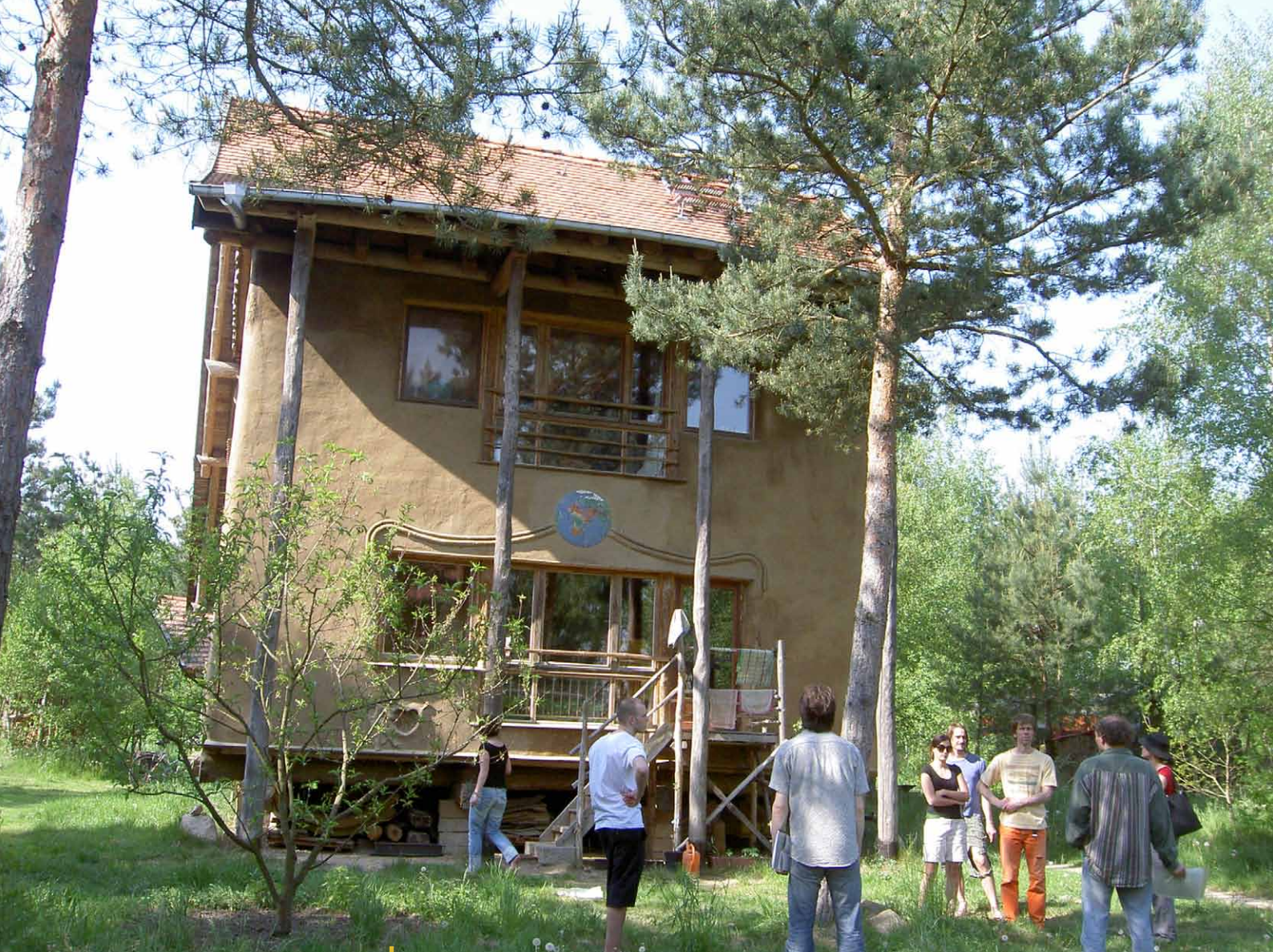
Une maison « faite à la main » en bottes de paille dans l'écovillage de Sieben Linden.
