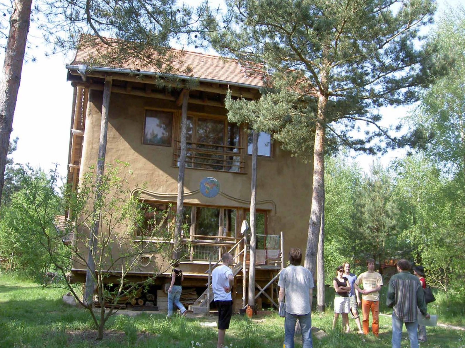
Ein „handgebautes“ Strohballenhaus im Ökodorf „Sieben Linden“.
